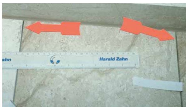
Bild 2: Offene Fugen, ca. 1 cm lang
