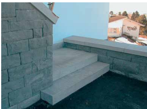
Mauerwerk und Treppe
