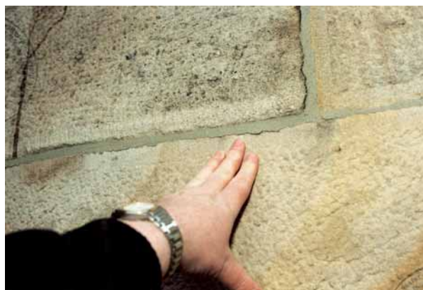
Bild 2: Beim Prüfen der neuen Verfugung
