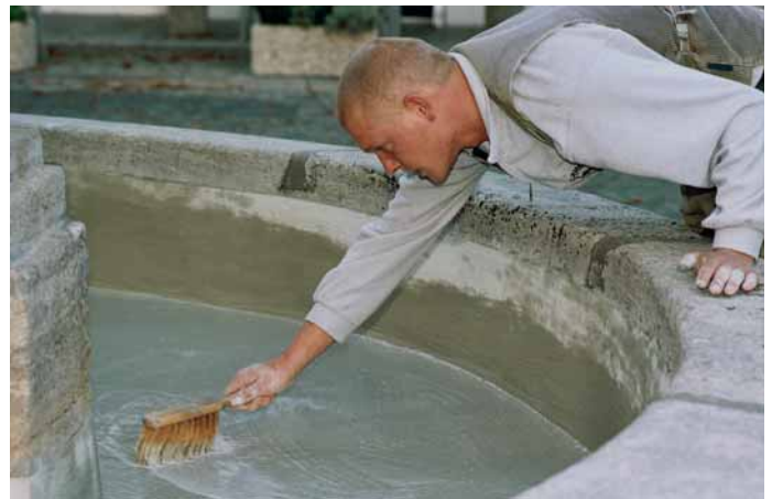
Die »CR 65 Dichtschlämme« von Ceresit wird von einem Mitarbeiter der Kalenborn Natursteinbetriebe am Beckenboden des Brunnen Margarethenhöhe aufgebracht.
