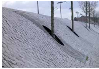
Der sanierte Deich in Hamburg-Finkenwerder
