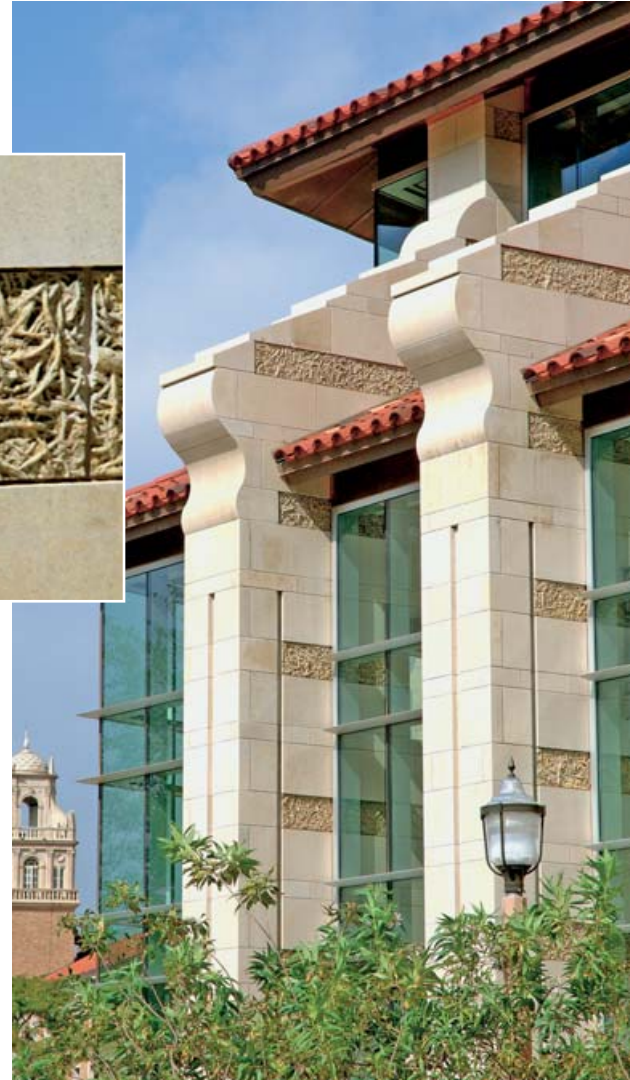
Eines der fünf Säulenpaare des Pavillons
