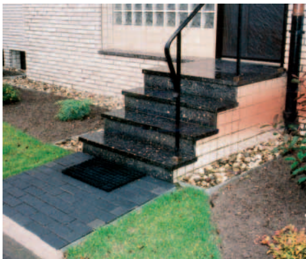
Bild 1: Gesamtansicht der Treppe und des Gehbelags
