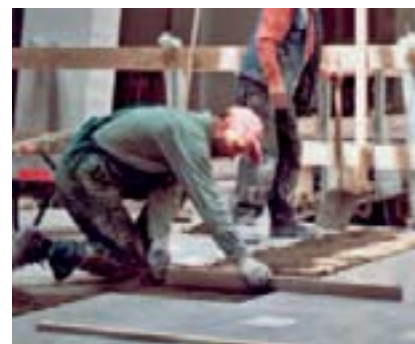
Das Mörtelbett wird mit einer Lehre abgezogen.
