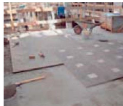
In Teilbereichen wurden Platten aus KELHEIMER MUSCHELKALK mit Einlegern aus Jurakalkstein verlegt.
