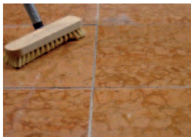
2. Lithofin LÖSEFIX pur auftragen und mit Schrubber verteilen
