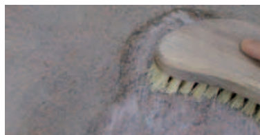
Einbürsten mit Lithofin MN Zementschleierentferner
