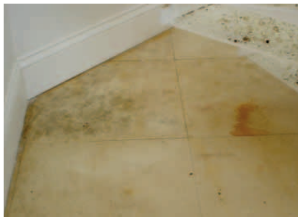
Türkischer Kalkstein ANTALYA WHITE, eingebaut während der Rohbaufertigstellung
