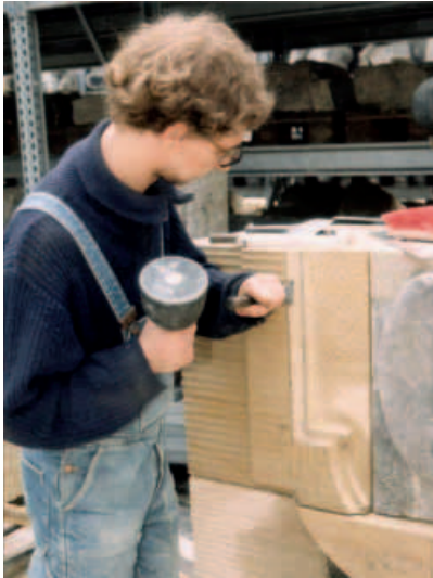
Ausarbeiten des Kehlschlagbandes an einem Fassadenstein
