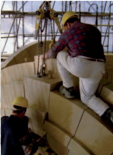
Schlussstein-Versetzen in der Laterne 2004
