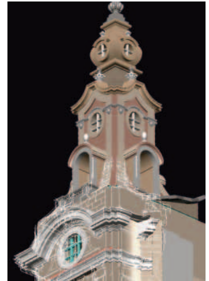
3-D-Aufmaß und Computermodell einer Treppenturmspitze
