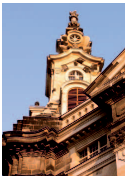
Treppenturmspitze E oberhalb des Ruinenteils
