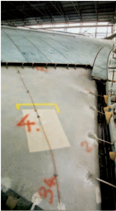
Detail der Dachanschlusskante an der Nordseite des Gebäudes. Um die Reinigung der Regenrinne zu erleichtern, sind die Abdeckplatten hier nur 40 cm breit.
