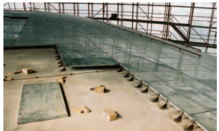
Die sonderangefertigten Lutz Bodyanker sind so konstruiert, dass jede einzelne Dachdeck-Platte Mannlasten tragen und für Reinigungsarbeiten separat demontiert werden kann.
