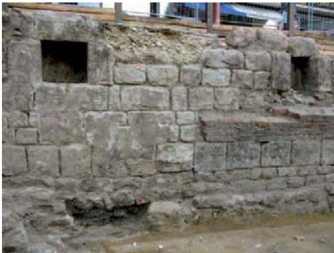
So sahen die Reste des Kellers aus, bevor der »Umbau« begann.
