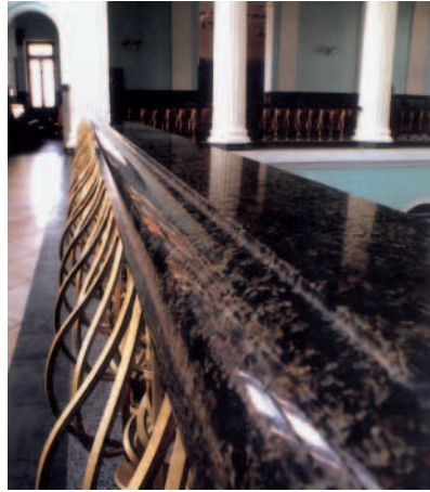
Profilierte Atriumeinfassung aus Rotem Granit von Volhontet Banchi.
