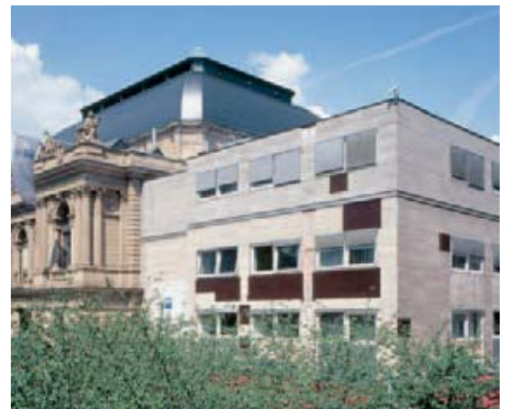
Westflügel nach dem Umbau 2004, Ansicht von der Börsenstraße
