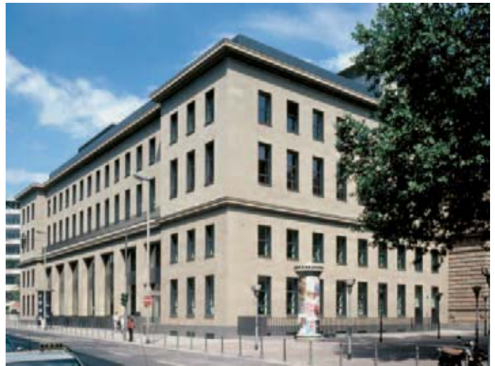
Ecke Börsenplatz/Schillerstraße nach dem Umbau 2004
