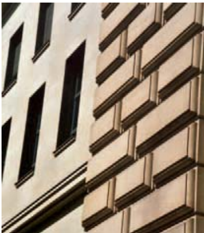
Renovierung mit zwei verschiedenen Sandsteinen: die Quader des Risalits und die Platten des neuen Westflügels (Börsenstraße)
