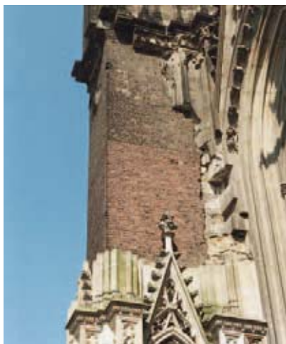
27 500 Ziegelsteine wurden für die Vermauerung des Lochs benötigt. (Zustand im April 2002)
