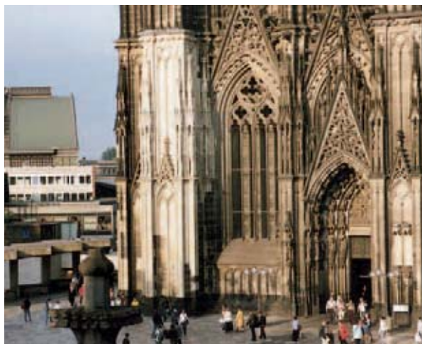
Rechtzeitig zum Katholischen Weltjugendtag in Köln wurde die Verkleidung der Ziegelpombe fertig gestellt.
