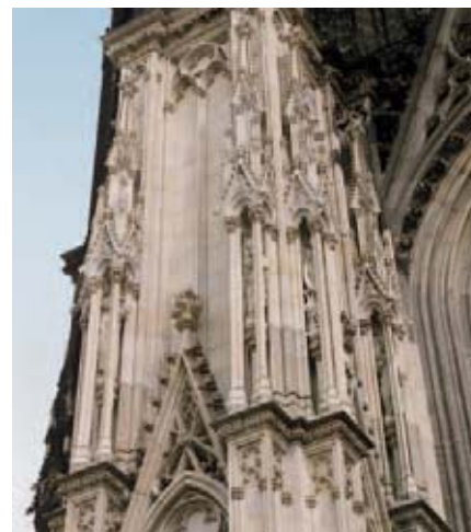
823 gehauene Einzelsteine, davon 124 aufwändige Bildhauerarbeiten aus OBERNKIRCHENER SANDSTEIN wurden versetzt.
