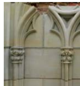
Versetzarbeiten der Kapitelle
