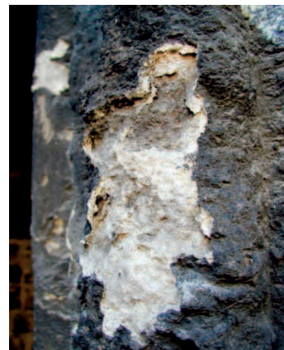
Typische Schäden: Es liegen mehrere Gipskrusten übereinander, die eine ausgeprägte Mürbzone mit zahlreichen Hohlräumen ausgebildet haben.
