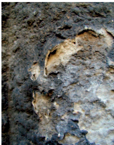
Typische Schäden: Es liegen mehrere Gipskrusten übereinander, die eine ausgeprägte Mürbzone mit zahlreichen Hohlräumen ausgebildet haben.
