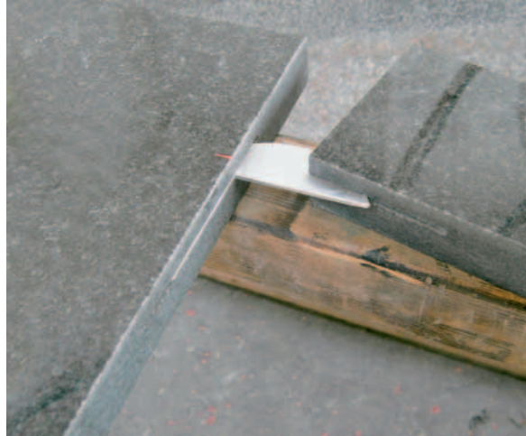
Bild 2: Einlegen des Fugen-Chips mit gleichzeitiger Verklebung
