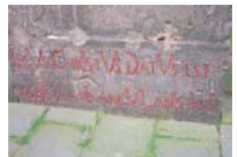
Der wiederentdeckte Grundstein
