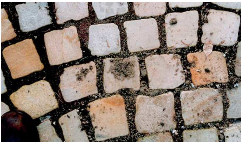
Häufigstes Schadensbild: Die Verfugung löst sich aus der Fuge.
