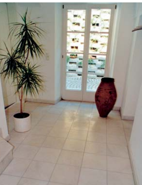
Im Streiflicht erkennbare Nutzungsspuren, u. a. durch Tausalz – den aufgeklärten Kunden stört es nicht.
