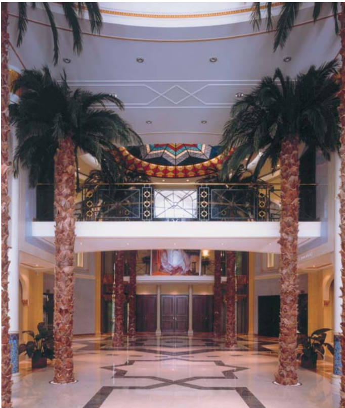
Der Lobby-Bereich mit einem zentralen, achteckigen Stern-Motiv in blauem AZUL BAHIA. Die Hauptfläche besteht aus dem hellen IMPERIAL WHITE.
