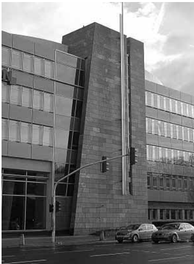
Teilansicht der Fassade
