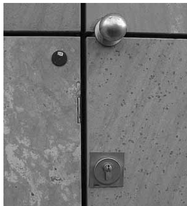
Die sichtbaren Elemente sind auf das Wesentliche beschränkt.
