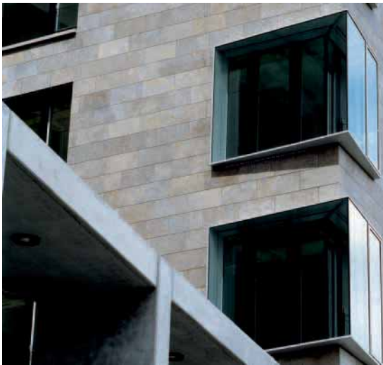
Fassadendetail mit ausgestellten Kastenfenstern.
