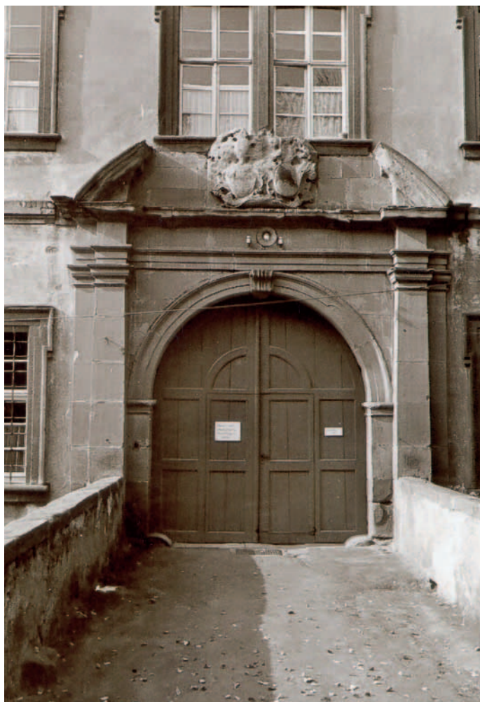
Das Eingangsportal mit Wappen im Vorzustand (Aufnahme: 1971).
