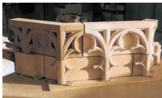
Das umlaufende Blendmaßwerk im Vorzustand (oben); unten: Teildarstellung der Neuanfertigung.
