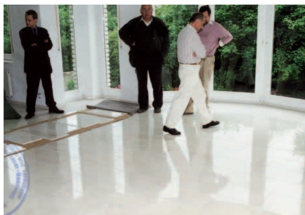
Auslegen der Ersatzplatten in Anwesenheit des kritischen Bauherrn.
