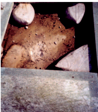
Bleibende farbliche Veränderungen in einem Naturwerksteinbelag aus ANDEER, verlegt auf Mörtelbatzen.
