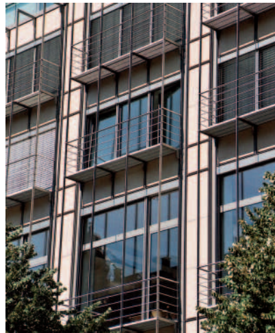
Nahaufnahme der Sandsteinfassade von der Kaiserstraße aus.
