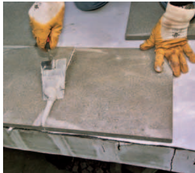
Stirnseitige Verklebung der CN 98 Best-Fertigestrichplatten.
