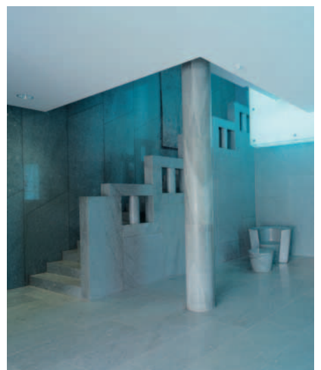
Foyer mit massiven Natursteinmöbeln aus Andeer Gneis. Auch Wände, Böden und Treppen sind aus dem grünen Graubündner Gneis.
