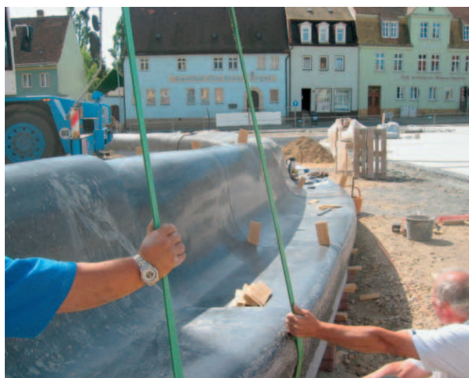
Die Montage vor Ort: Alles passte, sodass nur an wenigen Stellen geringfügig nachgearbeitet werden musste.
