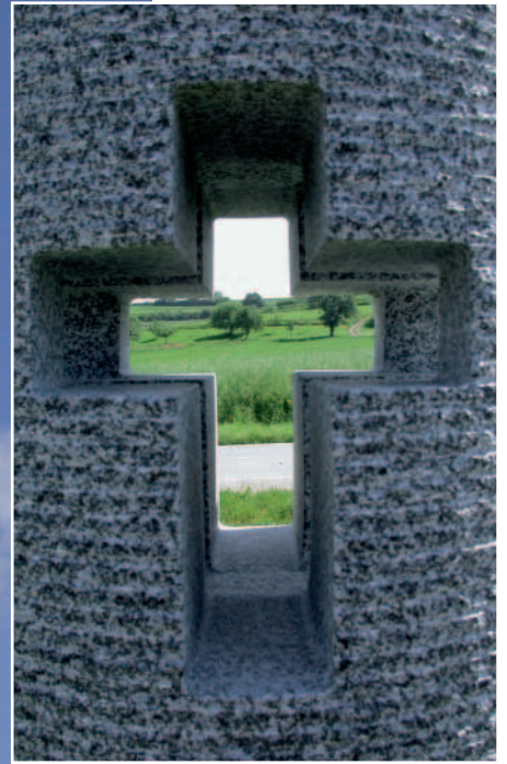
Feldkreuz von Gerold Jäggle aus einem »Guss«: Die Säule mit durchbrochener Kreuzform realisierte die Firma Kusser in Aicha mit technischer Präzisionsarbeit aus einem Stück FÜRSTENSTEINER GRANIT.
