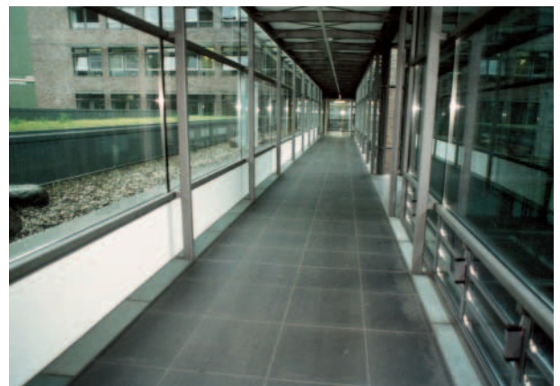
Bodenbelag, 60 / 60 cm, im Verbindungsgang EG.
