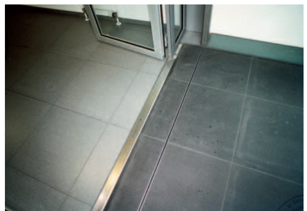
Rechts alter Belag (dunkler Werkstein), links neuer Belag (Keramik).
