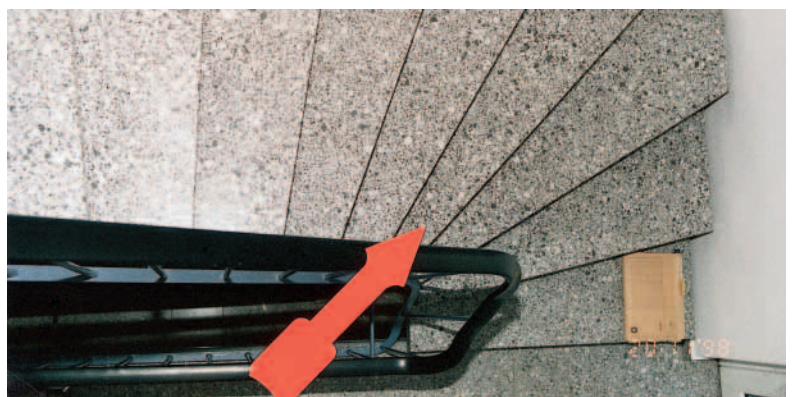
2 cm kleine Schweißnaht am Winkeleisen beim Austritt.
