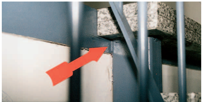
Zu schmaler Auftritt bei Stufe Nummer 4.
