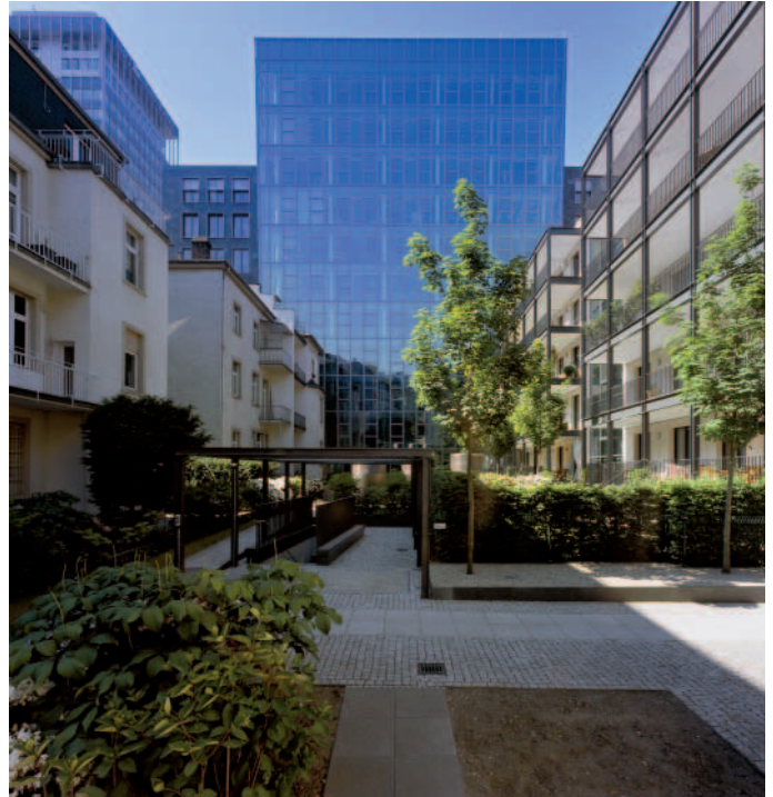
Blick in den neu geschaffenen Garten zwischen den Stadtvillen Oberlindau und Unterlindau.
