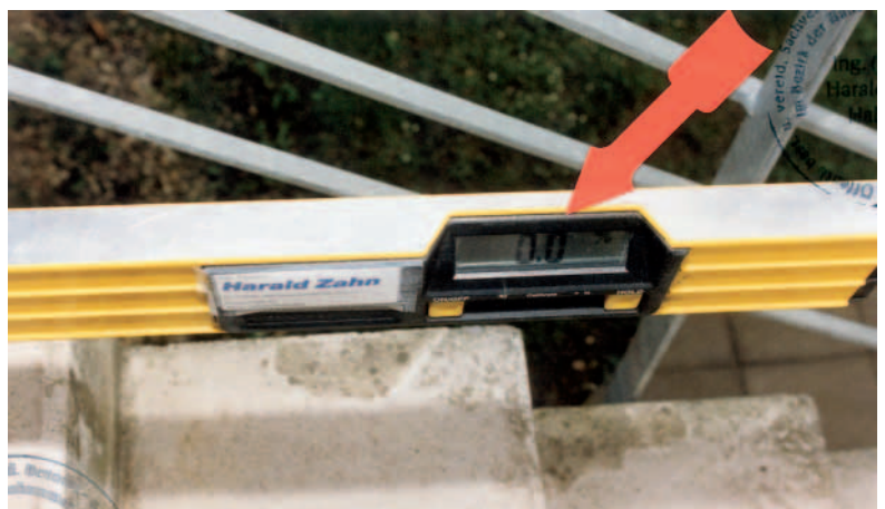
Bild 2: Kein Gefälle auf der Treppenstufe (Digitalanzeige).
