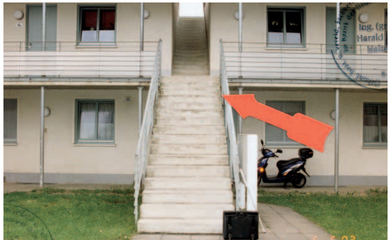
Bild 1: Treppenlauf mit angeblicher Unfallstelle.
