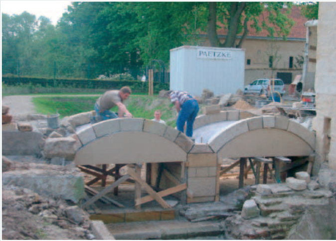
Die absenkbaren Lehrschalungen konnten nach dem Versetzen der Steine problemlos entfernt werden.
