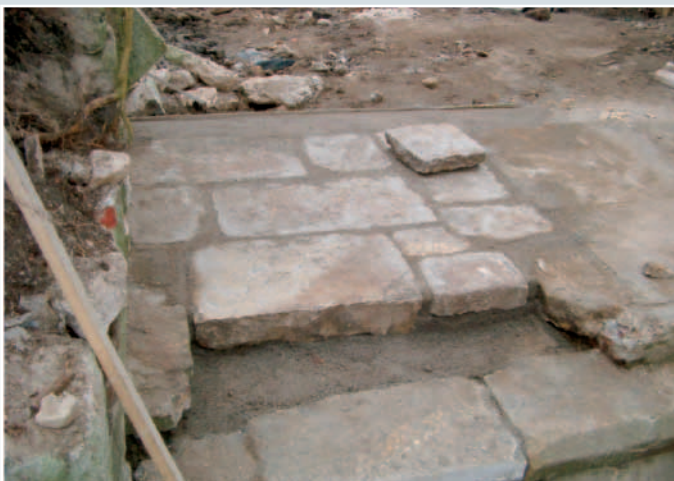
Der Flussbettboden aus Sandstein und die Widerlager waren erhalten. Der Mittelpfeiler wurde in der üblichen Bootsform gesetzt.
