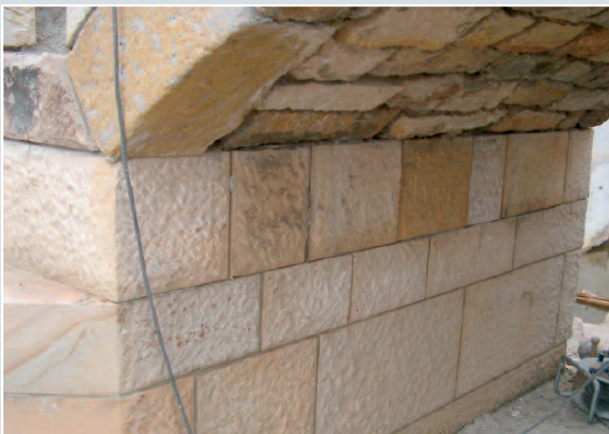
Neben historischen Werksteinen aus GRAVENHORSTER SANDSTEIN wurde BENTHEIMER SANDSTEIN als Ersatzmaterial verwendet.
