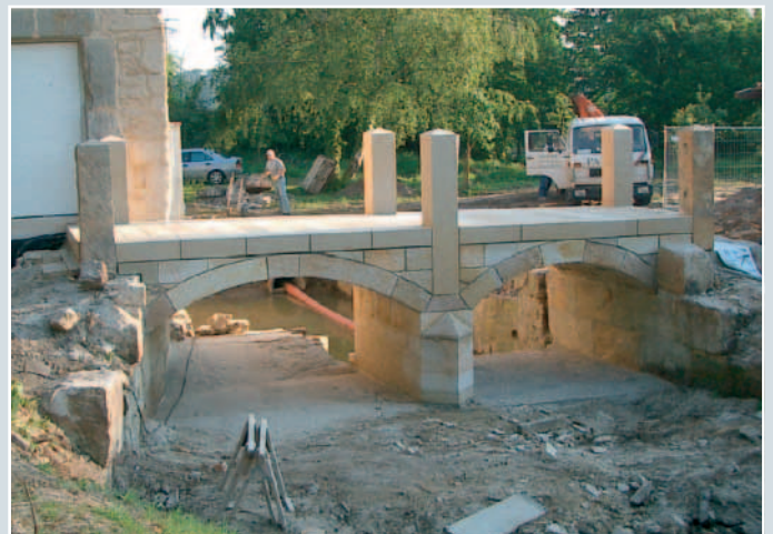
Die fast fertige Doppelbogenbrücke mit einem Oberboden aus Sandsteinplatten.
