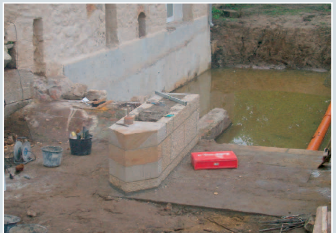
Der Flussbettboden aus Sandstein und die Widerlager waren erhalten. Der Mittelpfeiler wurde in der üblichen Bootsform gesetzt.
