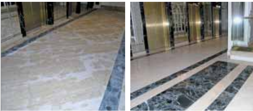
Travertin nach Grobschliff und Verspachtelung (linkes Bild); Rechts die Travertinbelagsfläche nach Politur und Kristallisation Fotos: MGT
