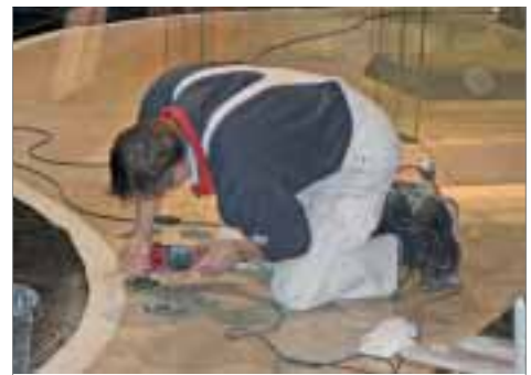
Bei qualitativ hochwertigen Schleifarbeiten werden die Ränder und Anschlüsse in Handarbeit (Steinmetzarbeit) durchgeführt. Foto: MGB
