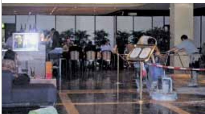
Schleifarbeiten in einem Hotel bei laufendem Betrieb: Die Beeinträchtigung durch Schmutz und Lärm hält sich in Grenzen. Foto: MGT
