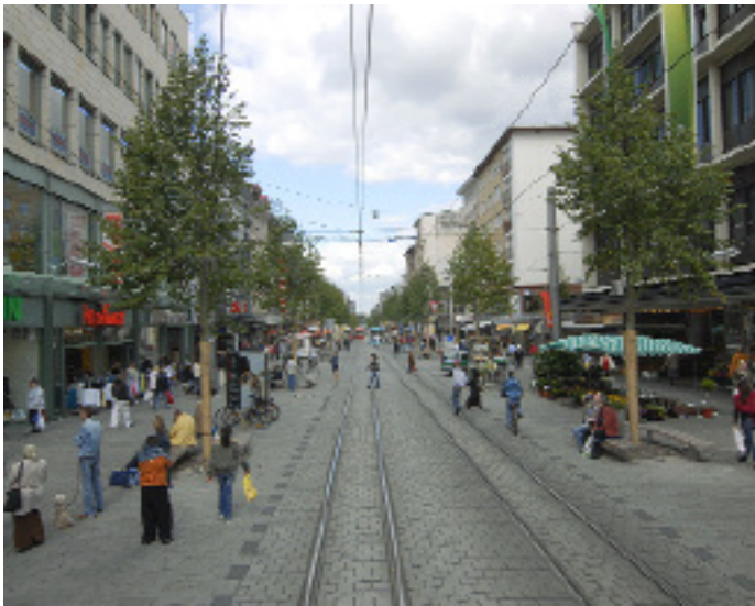
Fußgängerzone in Mannheim, ausgeführt von Besco
