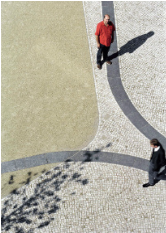
Umweltbundesamt Dessau, ST raum a. Landschaftsarchitektur; Mosaiksteinpflaster aus THÜRINGER TRAVERTIN; Bewegungslinien aus Granit, geflammte Oberfläche, Seiten und Unterseiten gesägt
