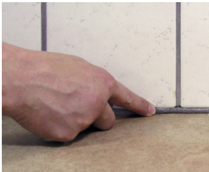
Hinterfüllen der Fuge mit einer Rundschnur
