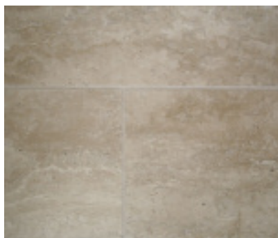
Fugenbild eines Travertinbelags mit gesägten Kanten
