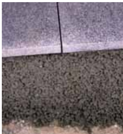
3 cm dicker Granit mit 15 cm dickem Monokormörtel
