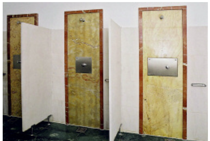
Mit Naturstein bekleidete Wandabschnitte im Nassbereich
