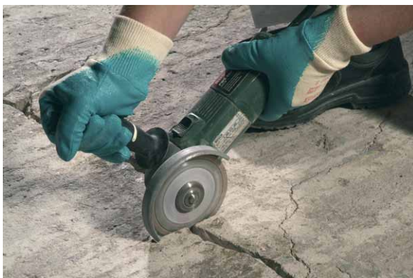
Einschneiden des Estrichs
