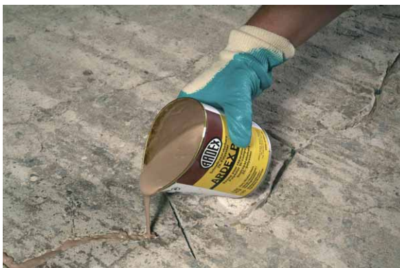
Einfüllen des Schnellreparaturharzes
