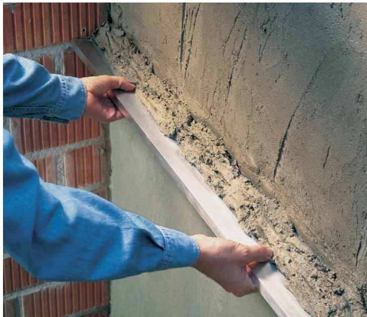
Aufziehen von ARDEX AM 100 an der Wand
