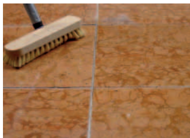
2. Lithofin LÖSEFIX pur auftragen und mit Schrubber verteilen
