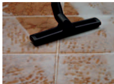
4. Lösung mit Nass-Trocken Sauger aufnehmen
