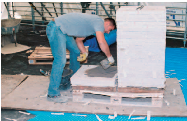
Auftragen von ELASTORAPID auf die Rückseite des Naturwerksteins.
