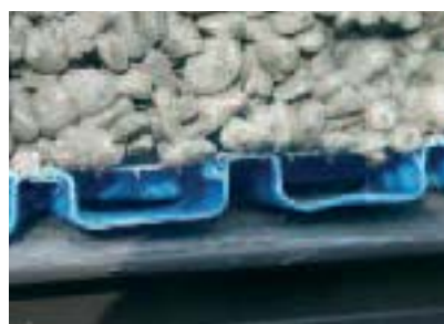
Verlegung auf Einkornmörtel mit einer speziellen kapillarbrechenden Natursteindrainage, hier AquaDrain(R)EK. Verhindert stauwasserbedingte Ausblühungen!
