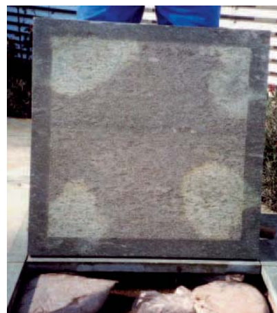
Bleibende farbliche Veränderungen in einem Naturwerksteinbelag aus ANDEER, verlegt auf Mörtelbatzen.
