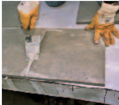
Stirnseitige Verklebung der CN 98 Best-Fertigestrichplatten.
