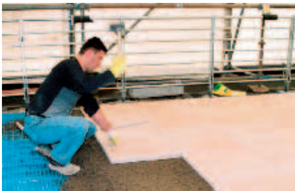
Herstellen eines Drainageverlegemörtels und Verlegung von Naturwerksteinen mit ELASTORAPID.
