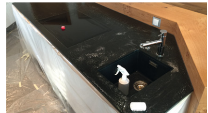
Eingebürsteter Imprägnierungsentferner in der abgeklebten Küche
