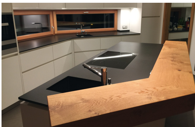
Die Küche nach der Reinigung und farbtonvertiefenden Schutzimprägnierung
